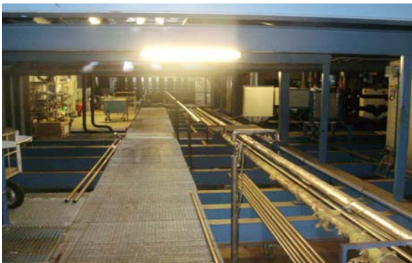
"Reforma Intercambiad. en fábrica de Campofrío" Burgos - 2.011 (1)
