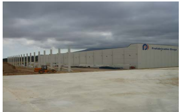
"Ampliación Nave Prefabricados Ólvega" Ólvega (Soria) - 2.009 (1)
