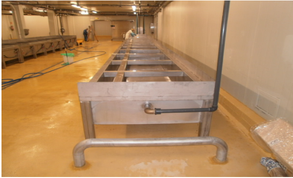
"Reforma Desgongelación en fábrica de Campofrío" Burgos - 2.011 (1)
