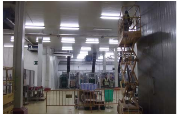
"Reforma Loncheados en fábrica de Campofrío" Burgos - 2.011 (1)
