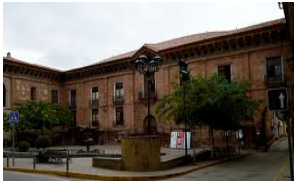
"Rehabilitación del Palacio de Argillo de Morata" Morata (Zaragoza) - 2.011 (1)
