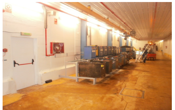
"Reforma Carga-baterías en fábrica de Campofrío" Burgos - 2.011 (1)
