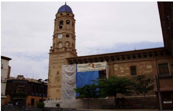
"Rehabilitación Iglesia de Morata" Morata de Jalón (Zaragoza) - 2.009 (1)
