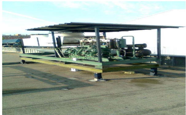
"Reforma Congelación en fábrica de Campofrío" Villaverde (Madrid) - 2.011 (1)
