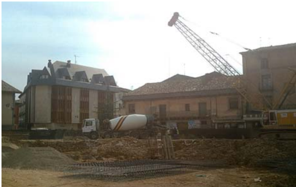
"Aparcamiento subterráneo en la Plaza Biscós" Jaca (Huesca) - 2.005 (1)
