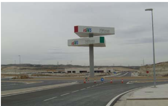
"Nave Industrial en PTR - Gesneuma" / Acciona Zaragoza - 2.007 (2)
