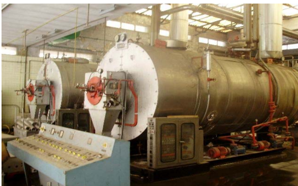
"Desmantelam. calderas en fábrica de Campofrío" Ólvega (Soria) - 2.012 (1)
