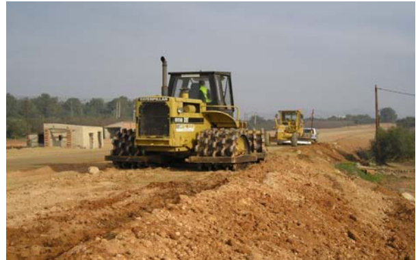
"Autovía Reus-Alcover" / Dragados-Arnó Alcover (Tarragona) - 2.006
