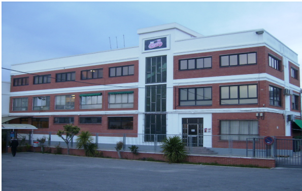
"Reforma Cubierta en fábrica de Campofrío" Torrente (Valencia) - 2.010 (1)
