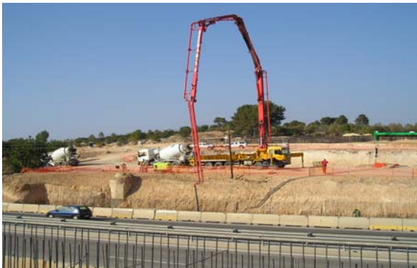
"Ampliac. Urbaniz. Port Aventura" / Dragados Salou (Tarragona) - 2.006
