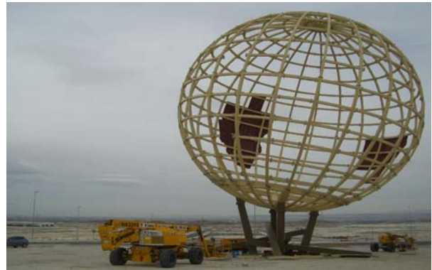
"Urbanización Parque Tec. Reciclado" / Acciona Zaragoza - 2.007 (2)
