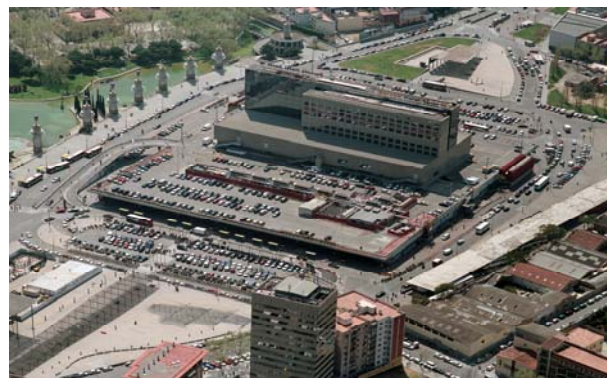
"Ampliació Estació de Sants" / Dragados-Tecsa Barcelona - 2.007 (2)
