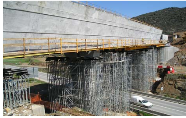
"Canal Segarra-Garrigues" / Dragados-Sorigué Ponts (Lleida) - 2.007 (2)
