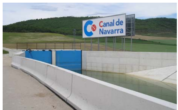
"Canal de Navarra. Tramos 4, 5 y 18" Añorbe (Navarra) - 2.004
