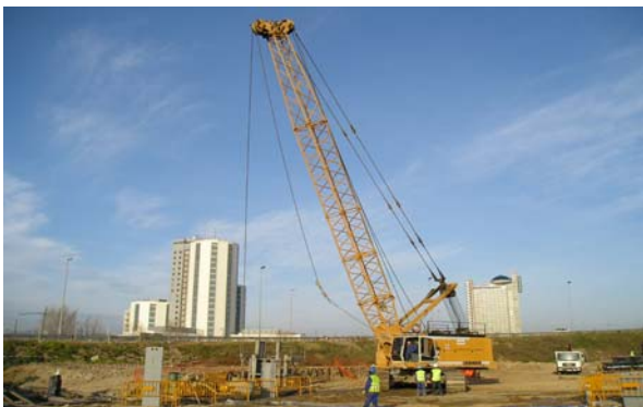
"Estación Metro Bellvitge" / Dragados-Tecsa L'Hospitalet (Barcelona) - 2.006
