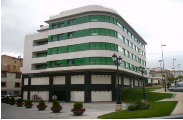
"Construcción de Edificio de 18 viviendas" Ólvega (Soria) - 2.007 (1)
