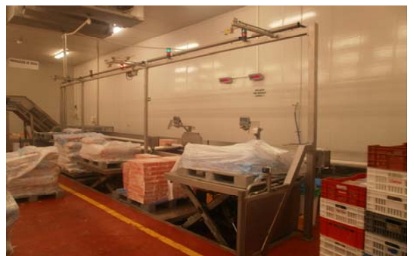
"Reforma Pesado-masas en fábrica de Campofrío" Villaverde (Madrid) - 2.011 (1)
