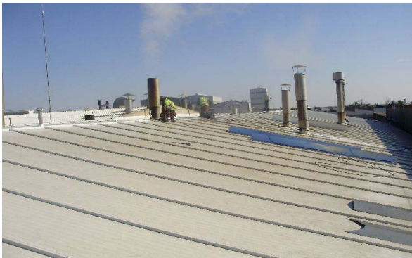
"Reforma Cubierta en fábrica de Campofrío" Torrente (Valencia) - 2.011 (1)
