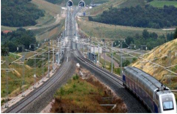
"Ensayos - Línea de Alta Velocidad AVE" / TEP Figueres (Girona)-Perpignan (Francia) - 2.010 (2)
