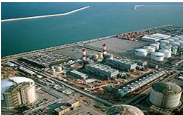
"Central de Ciclo Combinado - Puerto" / Téc. Reu Barcelona - 2.009 (2)
