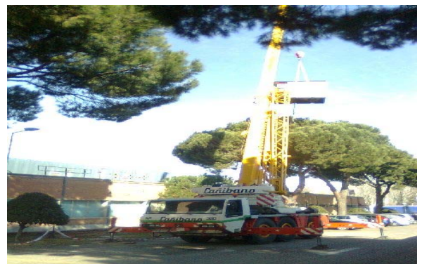
"Instalac. de compresor en fábrica de Campofrío" Villaverde (Madrid) - 2.012 (1)
