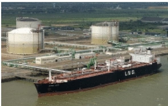
"Central de Ciclo Combinado - Francia" / Bloco Montoir de Bretagne (Francia) - 2.009 (2)
